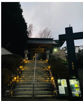
階段の照明を新調
